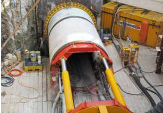
KW Doppelpower | Pressrohrvortrieb
