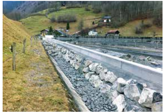
Ausgleichsbecken Engi | Umgehungsgewässer
