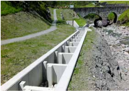
Ausgleichsbecken Engi | Fischtreppe
