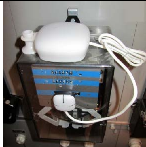
Montage am Stromzähler
